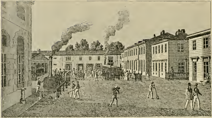
Abb. 179. Innere Ansicht des Bahnhofes der k. k. ausschl. priv. Kaiser Ferdinands-Nordbahn zu Wien. [Nach einem Original aus dem Jahre 1838.]
